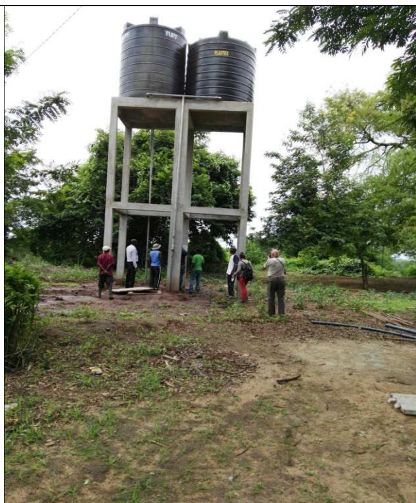
Torre dell'acqua ultimata (con cisterne a 10 m da terra)
