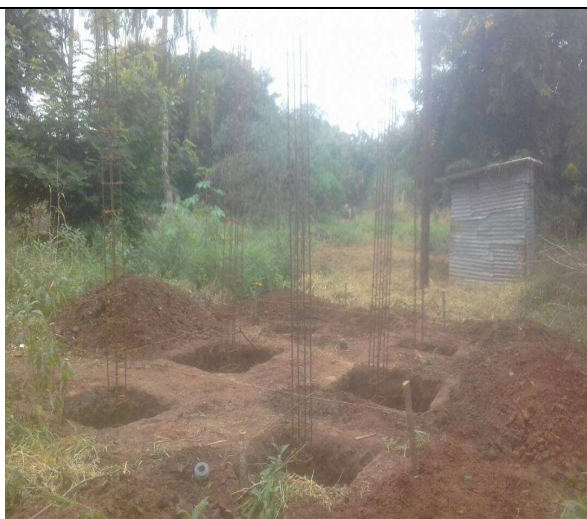
Inizio fondazioni per la torre dell'acqua
